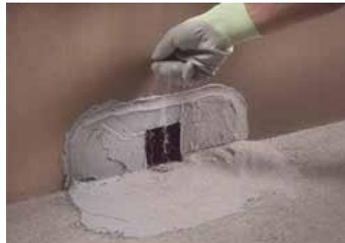
5. Выровняйте поверхность плоским шпателем и, пока материал еще свежий, посыпьте слоем кварцевого песка фракции 0,5 мм. Это придаст слою шероховатость и будет гарантировать хорошую адгезию соответствующих гидроизоляционных материалов **МАПЕИ**.
