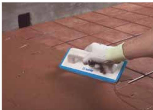
11. После нанесения гидроизоляционного материала МАПЕИ согласно определенной тех. карте, приклейте напольное покрытие и заполните швы.
