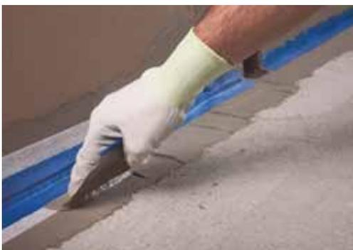
9. Нанесите второй слой гидроизоляционного материала МАПЕИ, полностью покрывая края ленты, таким образом, чтоб они находились между двумя слоями гидроизоляции.
