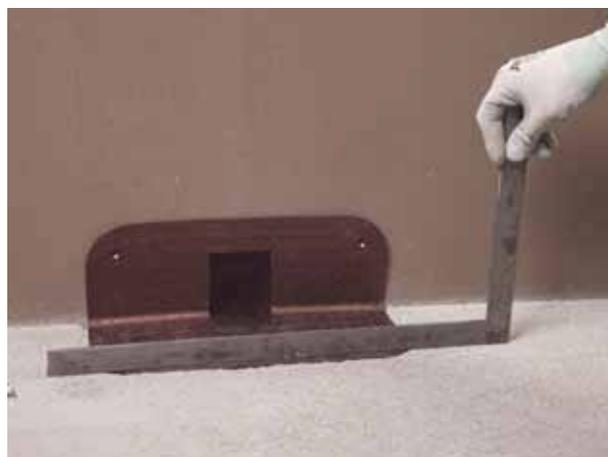
**1. Сделайте в парапете и настиле пола углубление достаточного размера, чтоб вставить Drain Front. Убедитесь, что элемент выставлен по уровню в горизонтальных и вертикальных плоскостях.**
