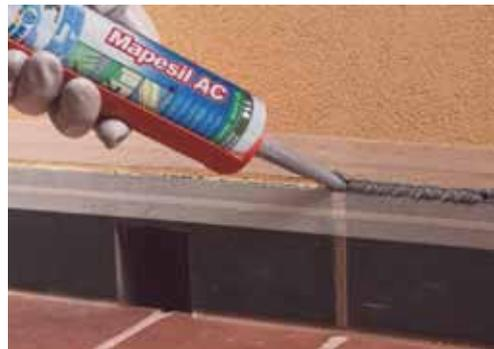
13. Заполните герметиком Mapefil AC швы примыкания плитус – стена, плитус – пол.
