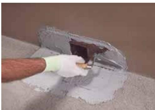
4. Нанесите второй слой **Adesilex PG4** методом «свежее по свежему», полностью покрывая **Drain Front**.
