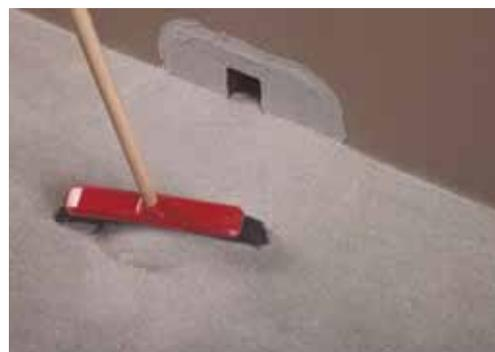
6. После отвердевания **Adesilex PG4** необходимо удалить незакрепленные частицы песка.
