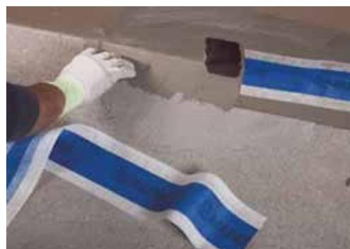
7. Нанесите первый слой гидроизоляционного материала **МАПЕИ** на чистую сухую поверхность углов.
