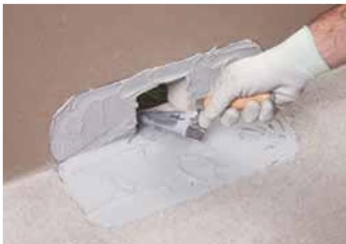
2. На сухое, чистое основание, нанесите с помощью плоского шпателя ровным слоем двухкомпонентный тиксотропный эпоксидный клей **Adesilex PG4**.
